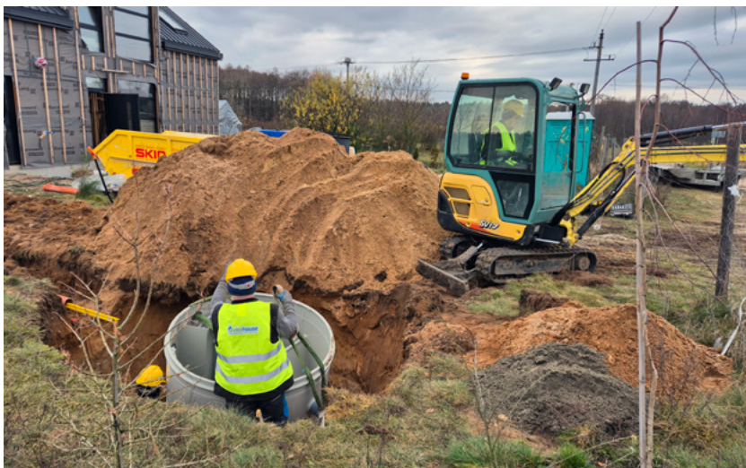
Prawidłowy montaż ma bezpośredni wpływ na późniejszą pracę i bezproblemową eksploatację oczyszczalni.
